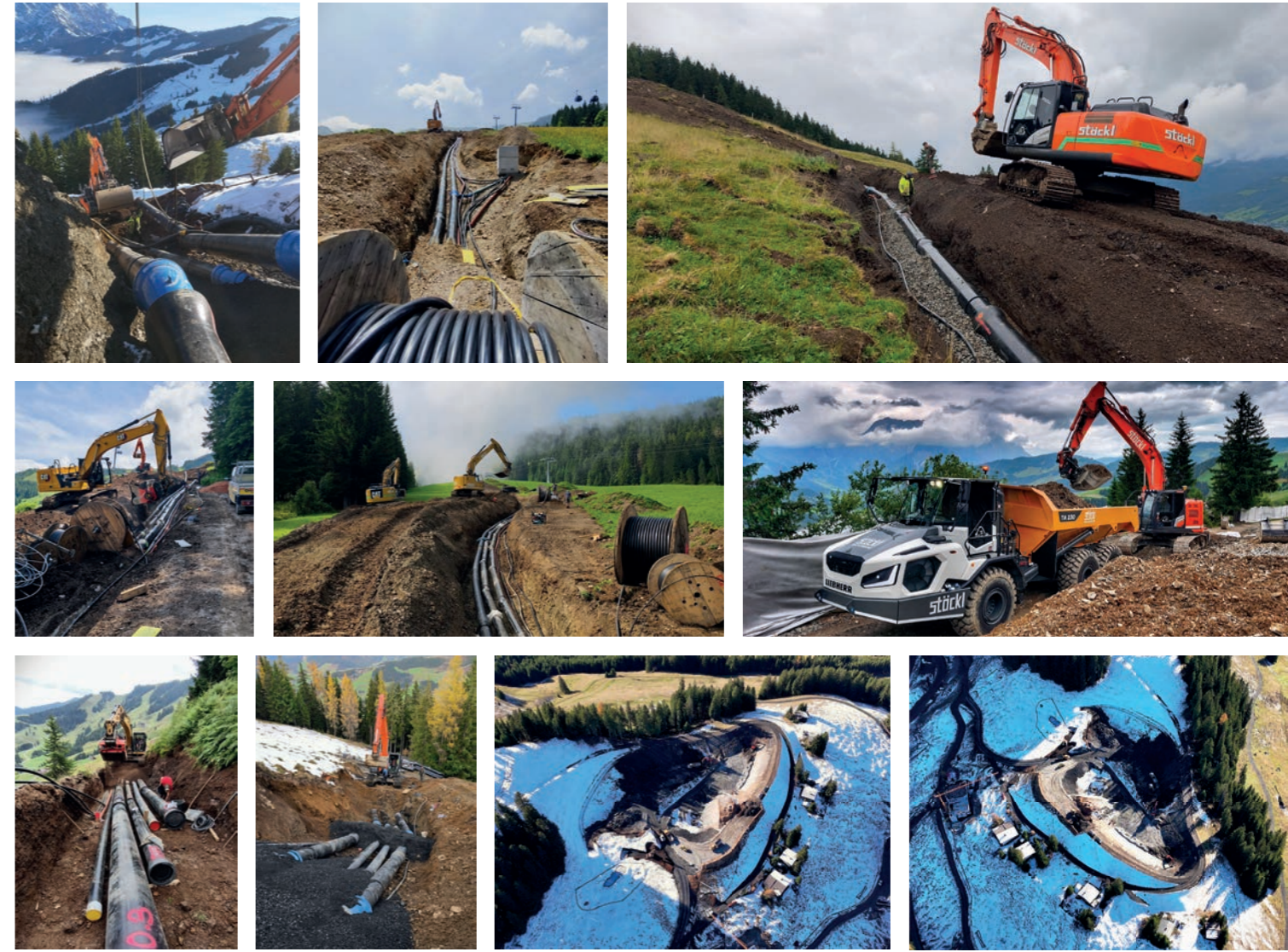
Speicherteich und Feldleitungsbau Steinerne Mandl | Maria Alm
