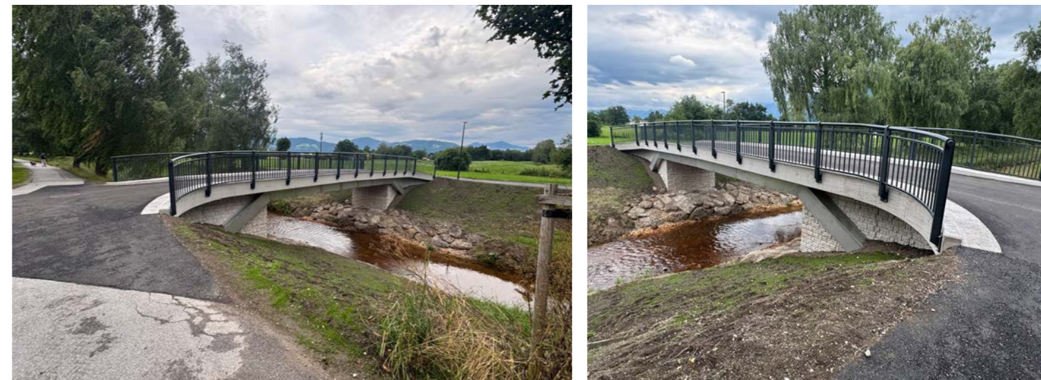
Abbruch und Neubau Brücke Steinerstrasse | Salzburg
