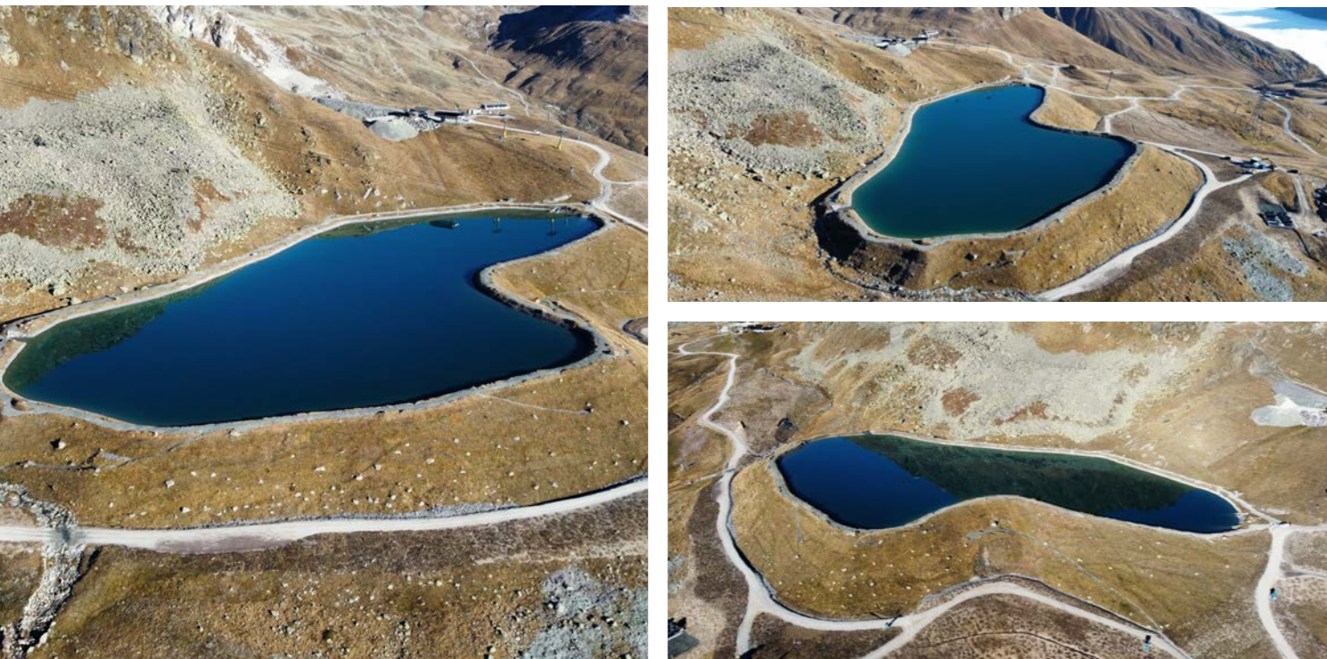
Speicherteich Nair Pitschen | St. Moritz
