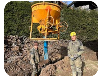
Zoran Lepir Kranführer Stöckl-Hochbau
