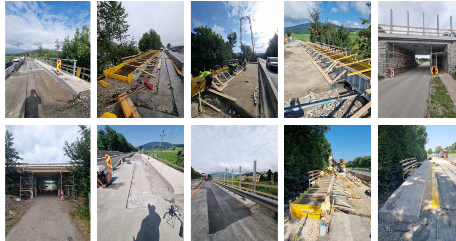
B156 Brückensanierungen von 3 Brücken | Anthering
