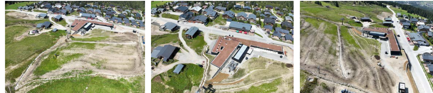
Fertigstellung Erdbau Duxer X-Press | Hochkrimml
