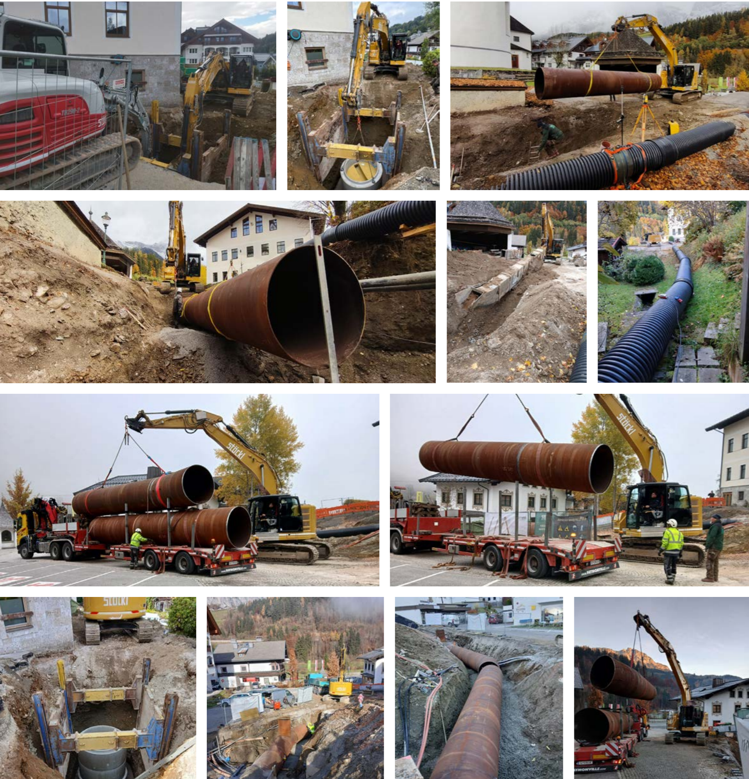
Verrohrung Mesnerbach | Leogang
