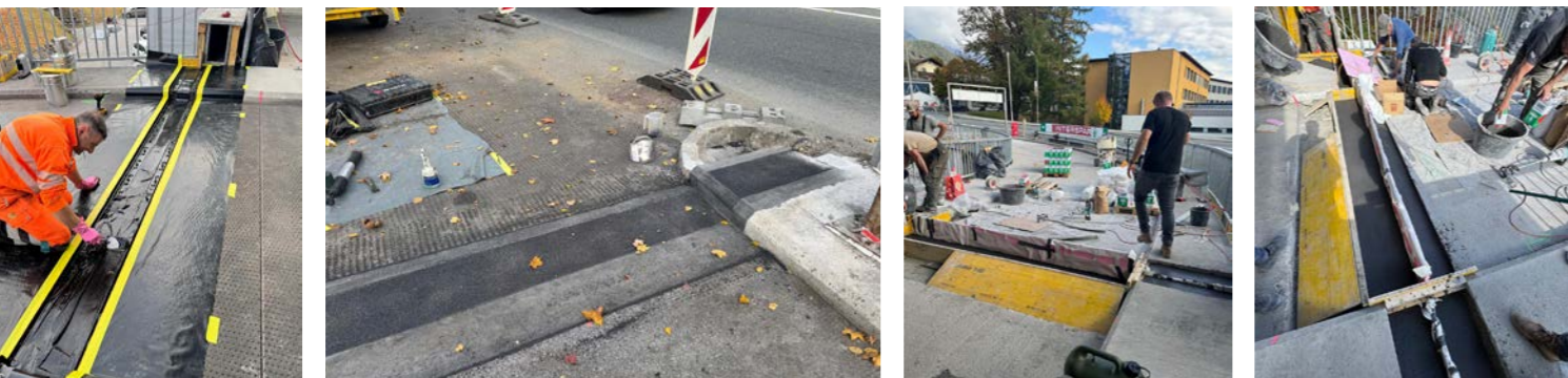
Interspar Rampenanierung | Saalfelden
